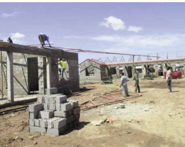
Das Friedenszentrum: Einbau der Dachträger.
